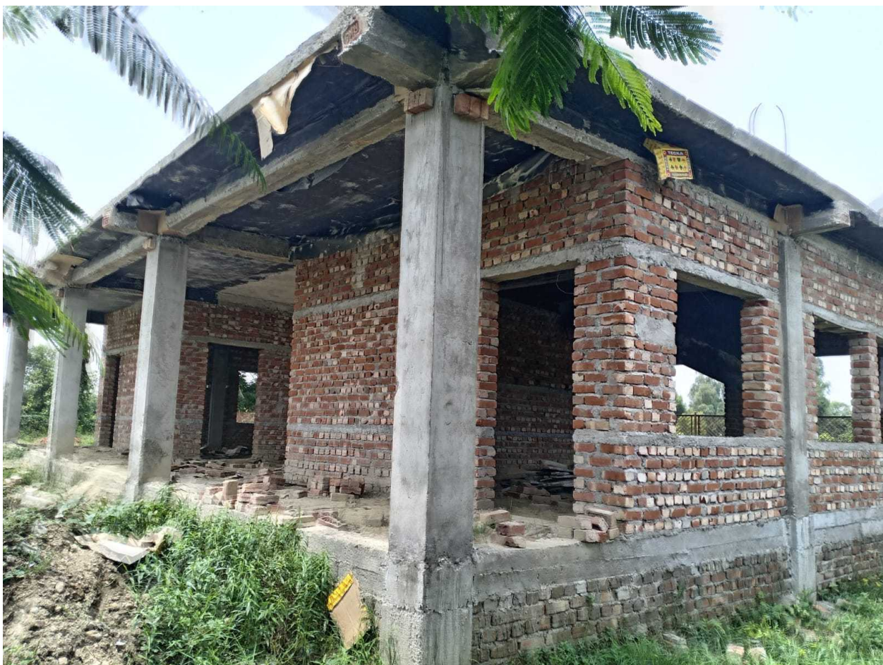
वडा नं १३ स्थित सेम नेपाल आ.वि. को २ कोठे भवन निर्माण
