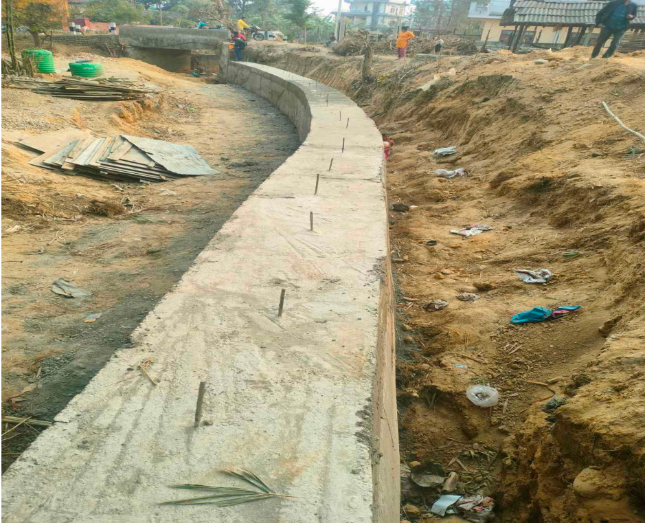
वडा नं १ स्थित खोल्सीमा वाल निर्माण
