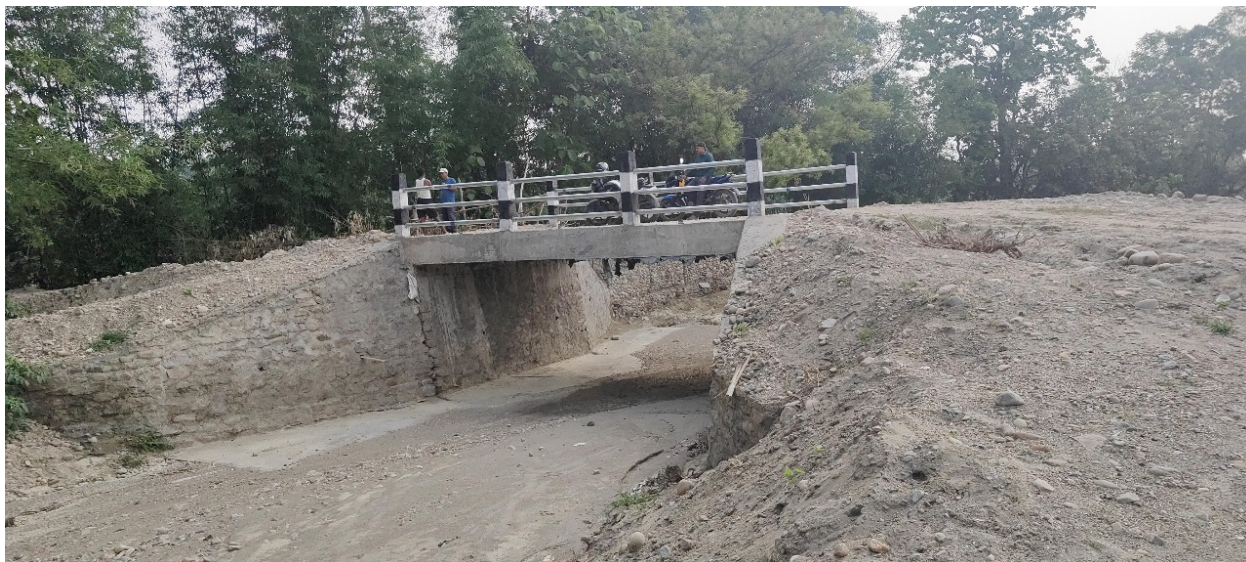
वडा नं ११ स्थित भरत टोलमा निर्माण भएको ६ मि स्पानको स्ल्याव कल्भर्ट
