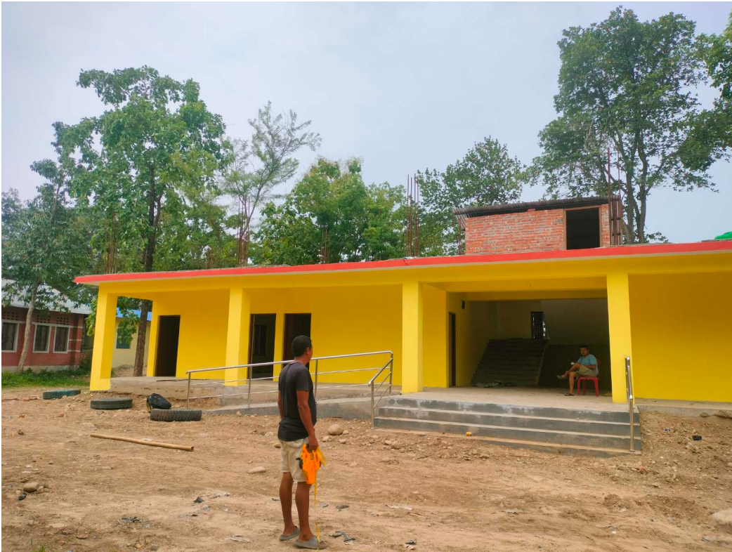
वडा नं १ स्थित देउराली मा.वि. मा चार कोठे भवन निर्माण
